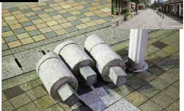
酒蔵通り (伊丹市) フラットな歩車道境界の歩道側に着脱可能なボードを設置している
