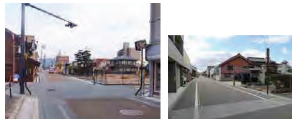
旧山陽道 宮市・国衛地区 (防府市) 交差点部における石張り舗装によるイメージハンプの設置
