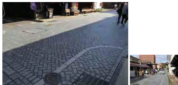
津和野本町・紙園丁通り (津和野町) 交差点部にも大型車の展開にも耐える網代貼り (フィッシュボーン) を採用
