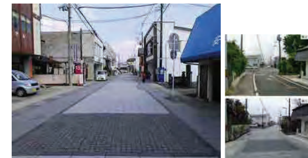
門前通り (白河市) 周囲と調和したピンコロ舗装によるハンプの設置
