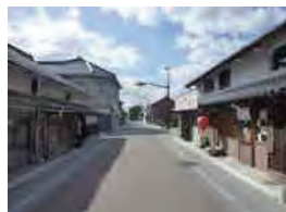
旧山陽道 宮市・国衛地区 (防府市) 車道部に路側帯の舗装がにじみ出すように設置
